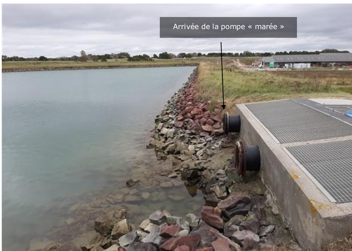
Figure 6 : La réserve d'eau de mer de 25 000 m 3
