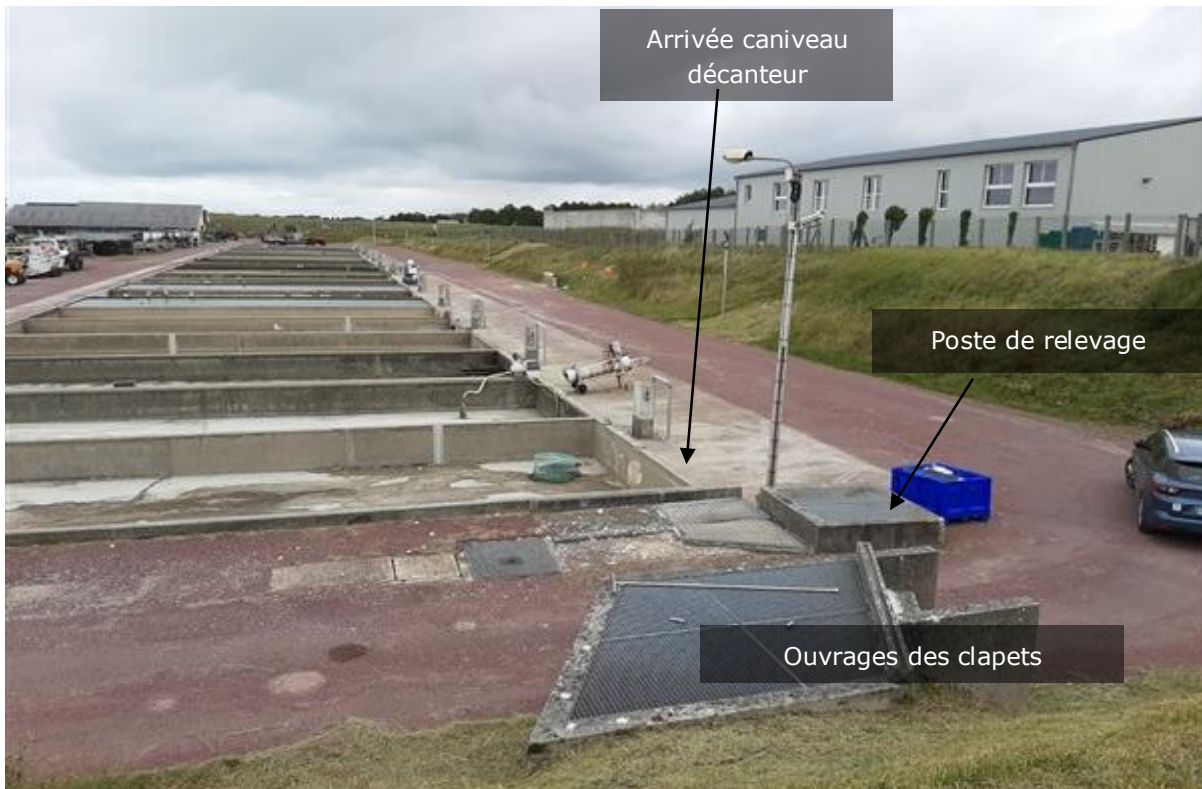
Figure 18 : Ouvrage de rejet des eaux de la zone conchylicole
