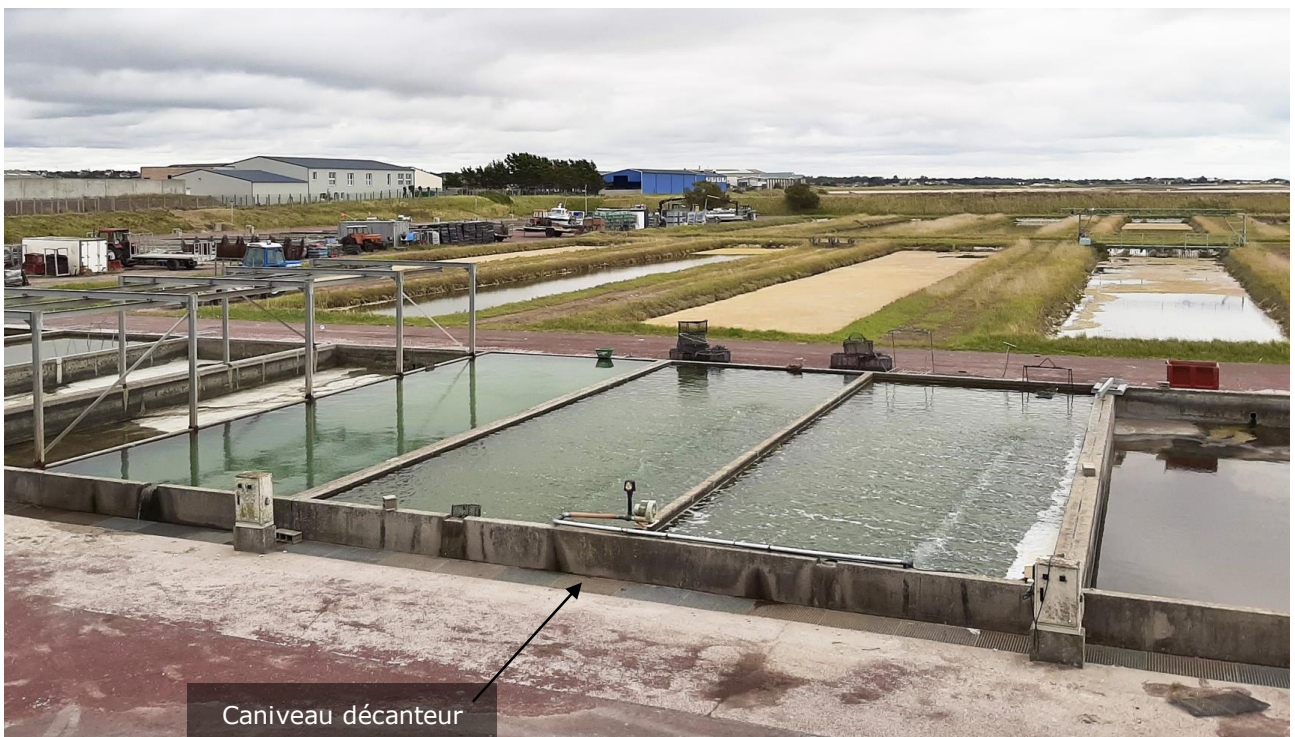
Figure 14 : Vues du caniveau décanteur longeant les dégorgeoirs
