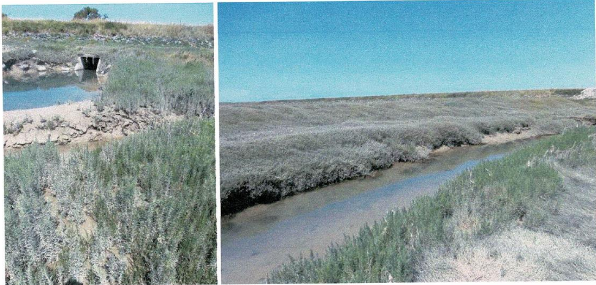
Photo 1 : ouvrage de rejet des eaux, avec végétation pionnière dont salicornes
